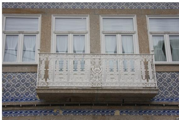
**Figuras 17 e 18** – Exemplos de varandas em ferro forjado e fundido.
