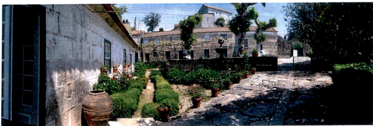
Núcleo seiscentista - casa com jardim formal e vista sobre anexos junto à cerca
