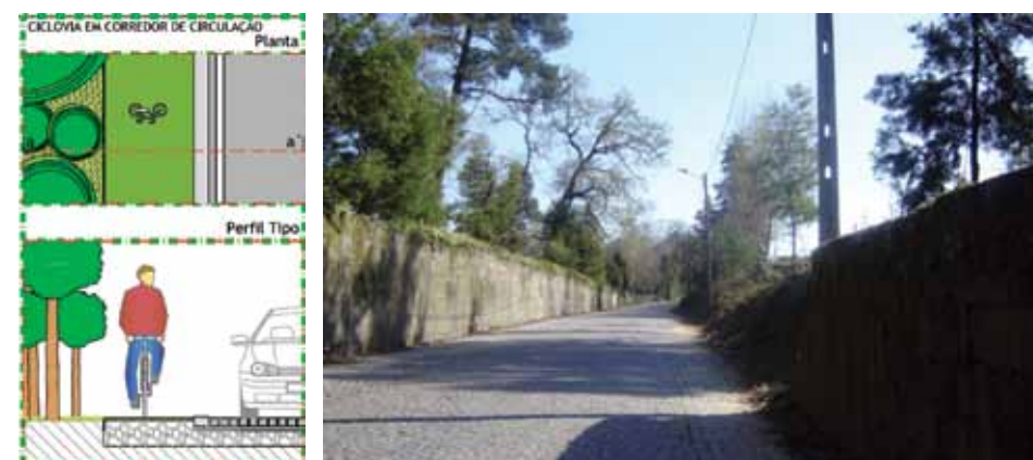
FIGURA 78 - Perfis Tipo da Ciclovía em Corredor de Circulação da Aveleda e fotografia do local
