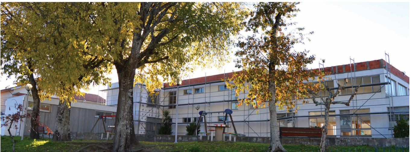
Estão a decorrer as obras de intervenção na EB1/JI de Cans, em Rio de Moinhos, com o objetivo de requalificar coberturas e fachadas, com a substituição integral da cobertura de fibrocimento com amianto, por painel tipo sandwich.
