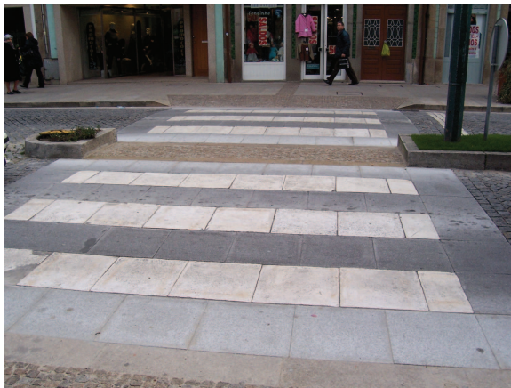
Figura 14. Exemplo de passadeira sobrelevada, devidamente assinalada ao nível do pavimento, de acordo com as especificações do código da estrada e com identificação tátil.
