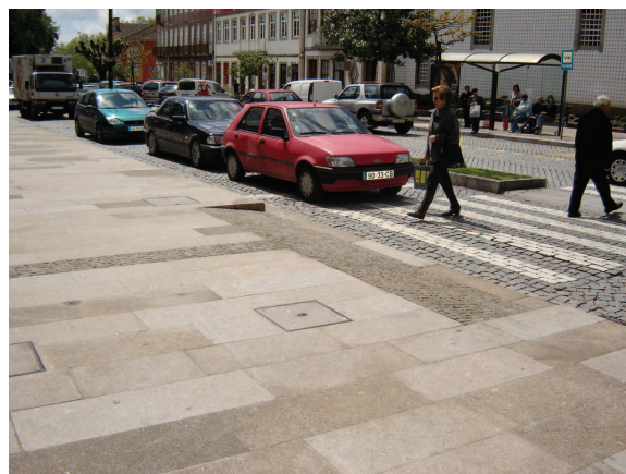
Figura 15. Avenida Sacadura Cabral – rebaixamento dos passeios nas zonas das passadeiras e colocação de textura diferenciada para os cegos em toda a área de intervenção.
