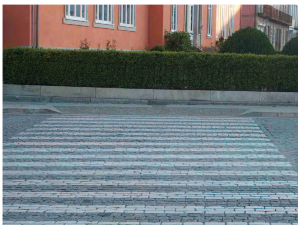
Figura 15. Avenida Sacadura Cabral – rebaixamento dos passeios nas zonas das passadeiras e colocação de textura diferenciada para os cegos em toda a área de intervenção.
