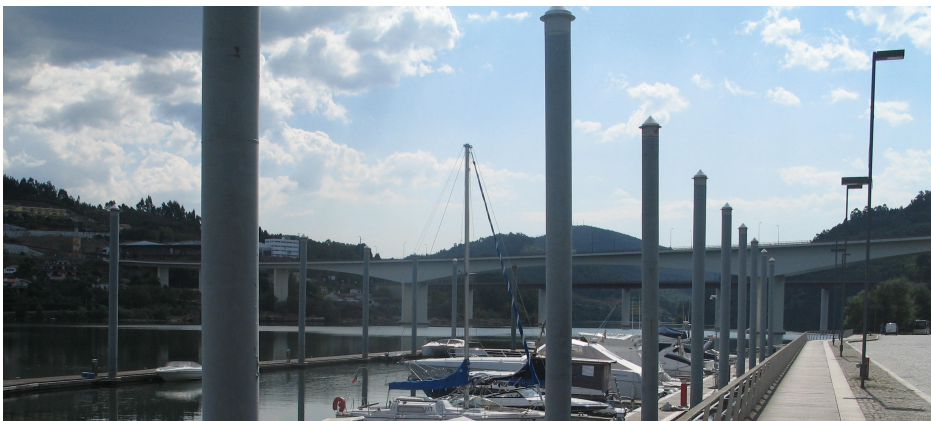
Fig. 9 – Cais de Entre-os-Rios e, ao fundo, Ponte do IC35
